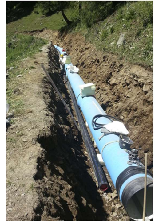
Verlegen Druckleitung + Trinkwasserleitung
