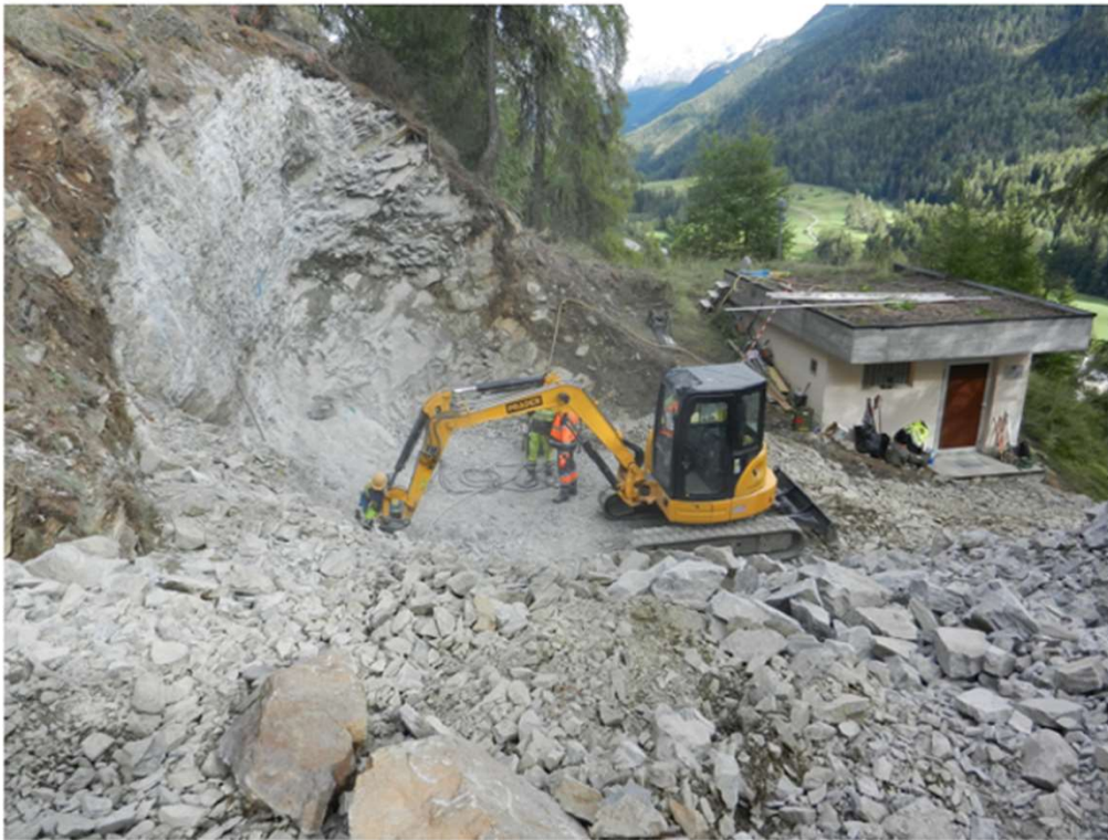
17.09.2013 Baustart Annexgebäude mit bestehendem Reservoir im Hintergrund
