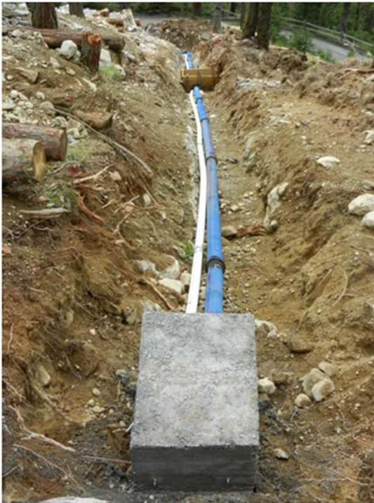
Betonwiderlager und Trinkwasserleitung (Guss)
